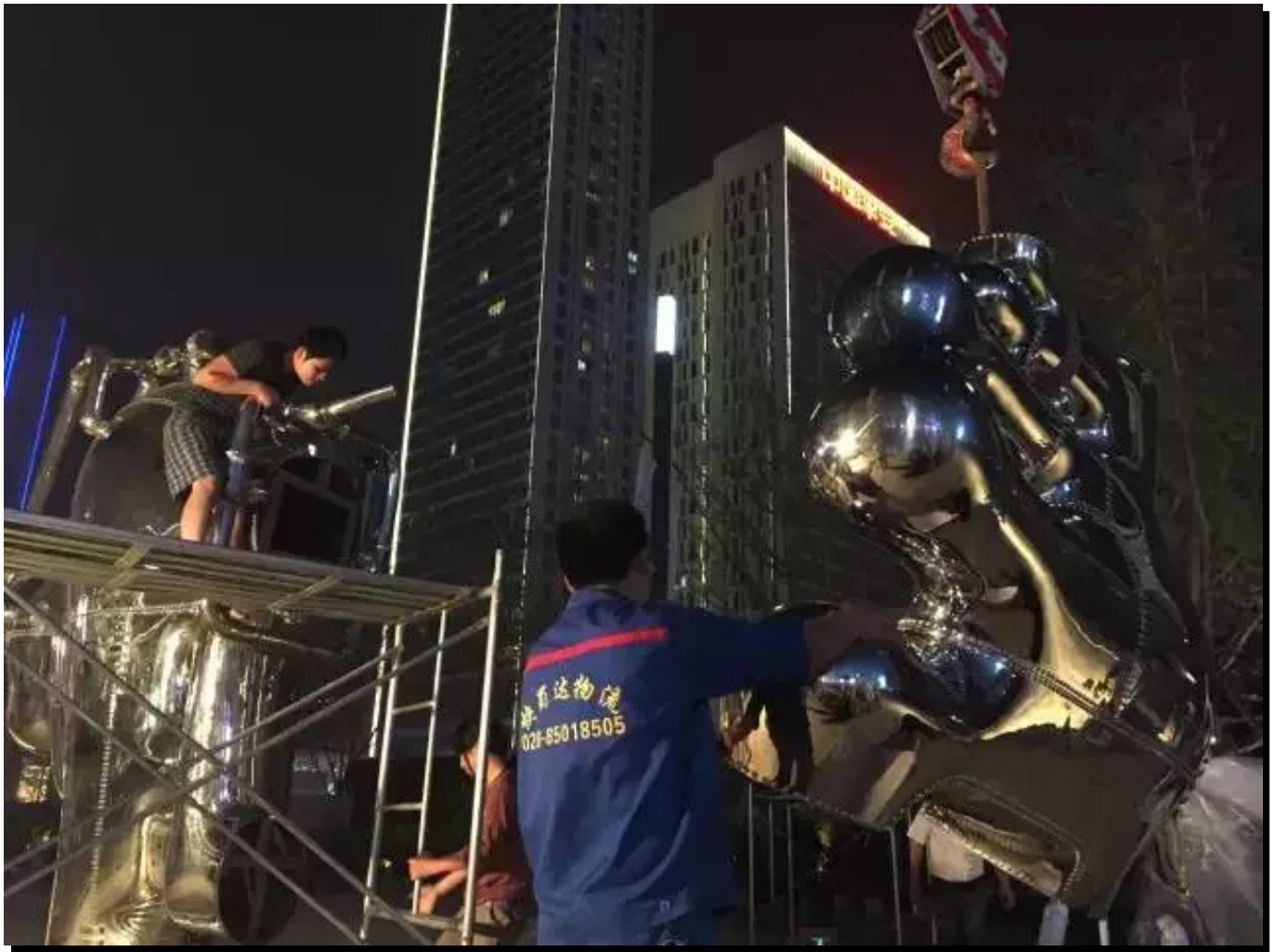
陈文令13米雕塑《城市公牛》正在安装
