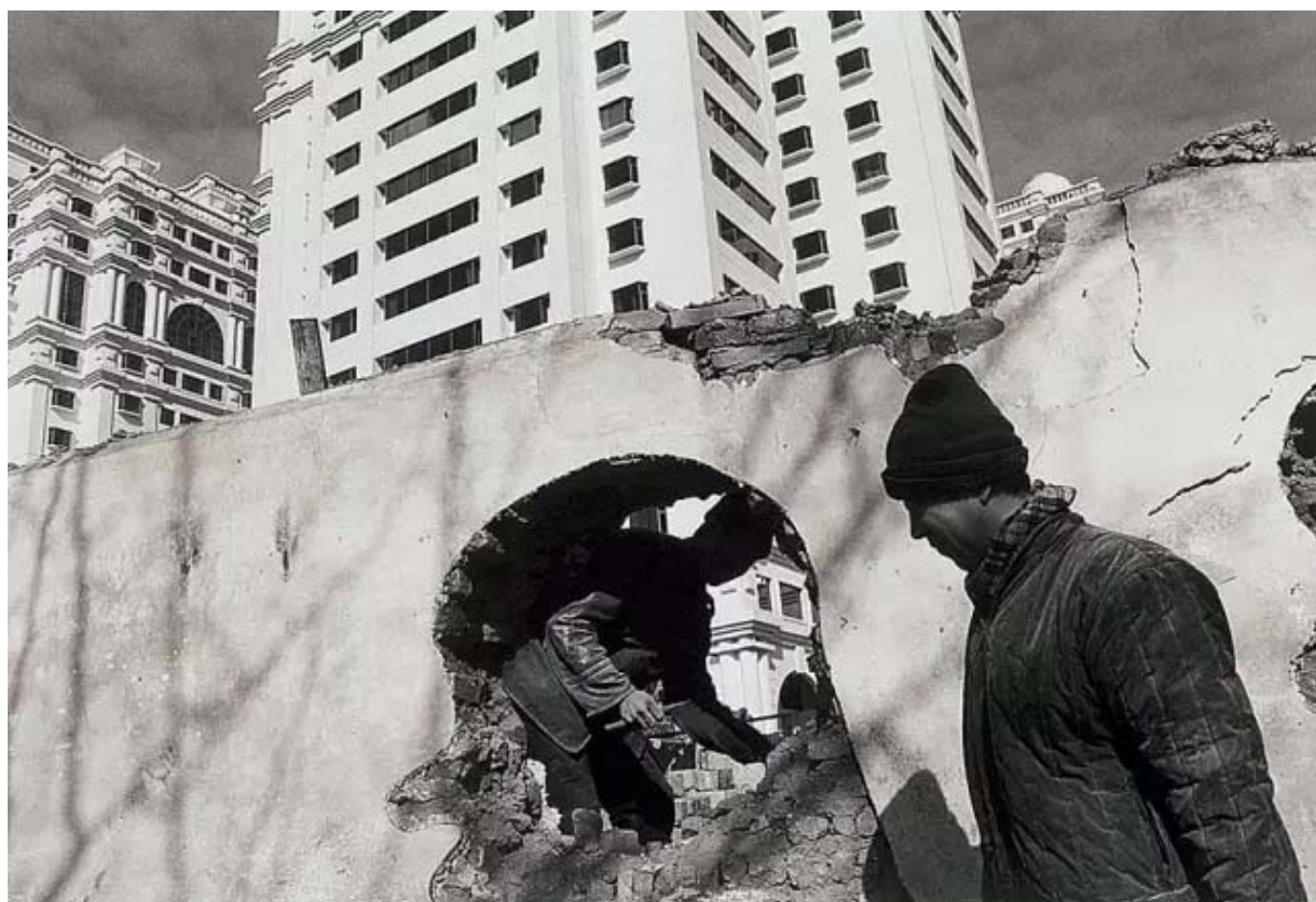
拆一 东二环富华大厦 北京 1998
